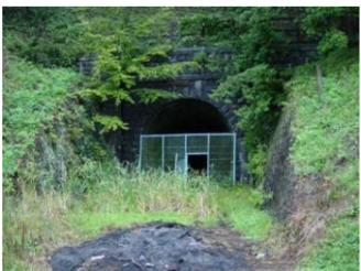
入り口には柵が設置され、立ち入りは禁止。内部では出水による水没、天井の一部崩落があり危険です。埋立てはされていらないため、反対側にも柵が設置されています。
